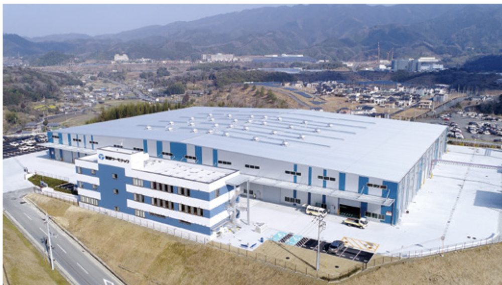
2019年に新設した橋本工場（最新の設備が稼働している）
